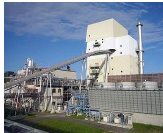
北越紀州製紙(株) バイオマス発電施設
