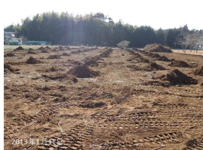
基礎用穴掘り
