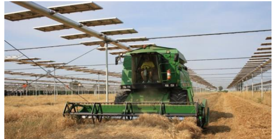
R.E.M. 社 (イタリア) 2軸追尾、大規模農業向け 遮光率15% 支柱高さ5m 間隔12m http://www.revolutionenergymaker.com/
