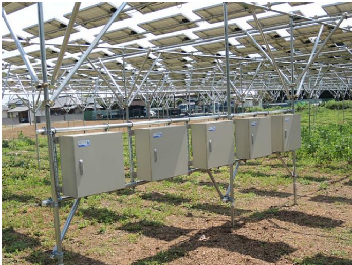
パワコン設置
