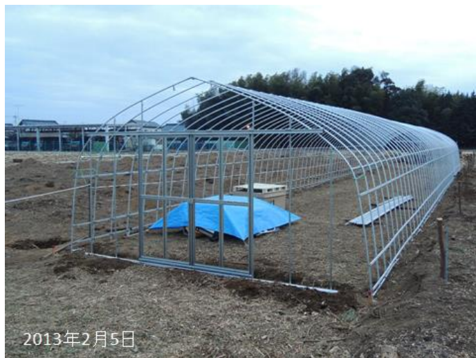
ビニールハウス設置
