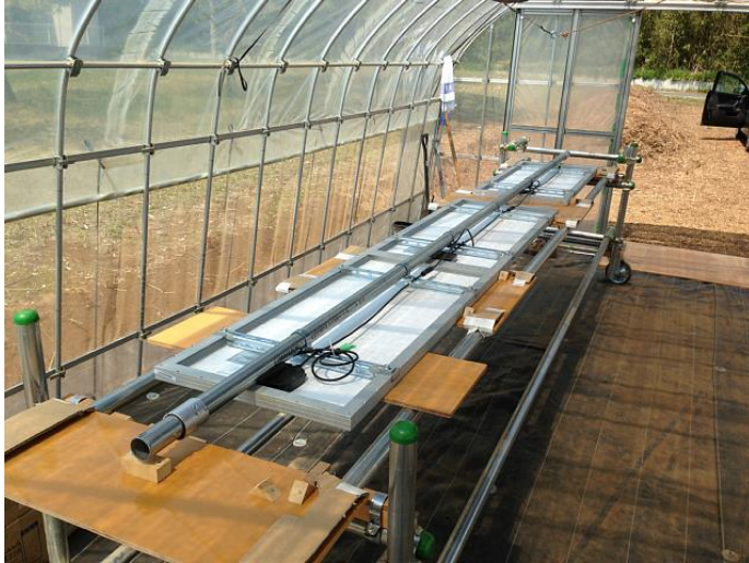
単管パイプにパネル固定
