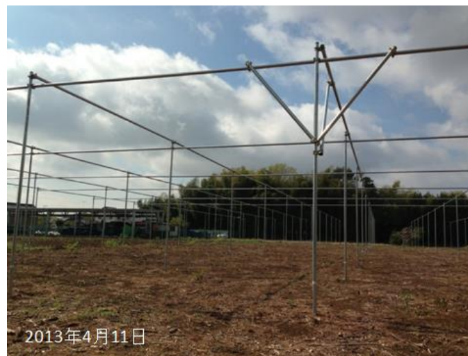
フレーム設置
