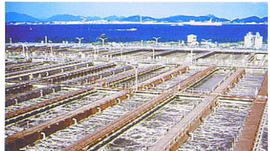
下水処理場の建設
