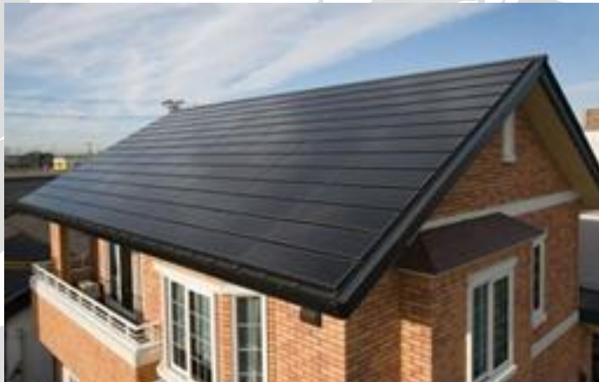
新築住宅への設置例
