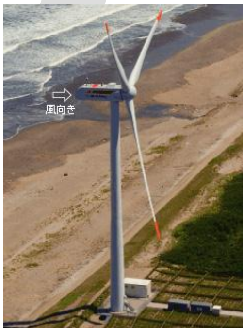
SUBARU80/2.0 ダウンウインド型風車
