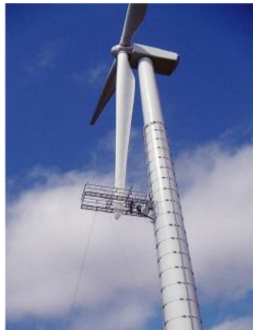
メンテナンス装置による作業状況
