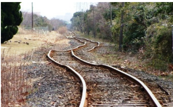
写真 1. 地震で線路が歪んだ大洗鹿島線。 (鉾田市)
