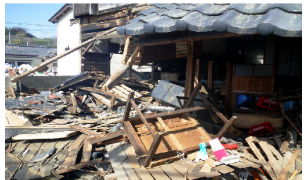
写真 2. 津波で倒壊した住宅。 (北茨城市)
