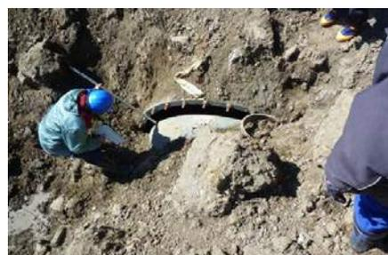
地震による農業用パイプラインの漏水調査状況
