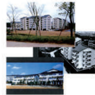
さくら団地 太陽熱利用ヒートポンプによる集合住宅 24戸の個別給湯システム(1985年)
