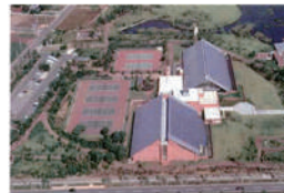
洞峰公園 国内最大級の太陽熱利用施設 集熱面積: 1912㎡, (1980年7月導入)
