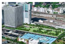
地域の防災拠点として避難者を受け入れ
